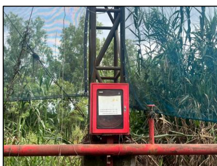
รูปที่ 2-43 ท่อน้ำดับเพลิงบริเวณรอบลานกองเก็บกากอ้อย
