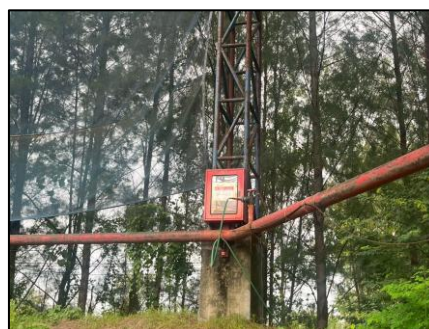
รูปที่ 2-43 ท่อน้ำดับเพลิงบริเวณรอบลานกองเก็บกากอ้อย
